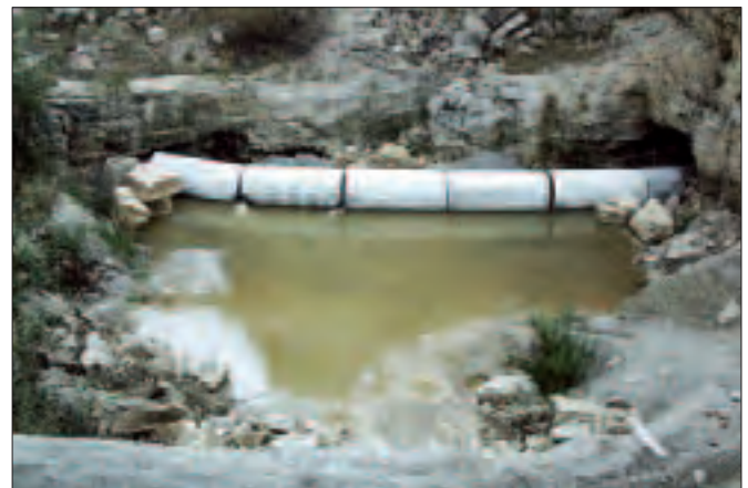
Abb. 12: Verrohrung der unterirdischen Schandtauber vor Auffüllung des Steinbruchs; Foto Archiv Arge Höhle und Karst Stuttgart.
