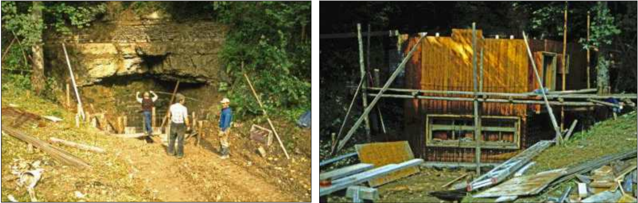
Abb. 10 u. 11: Zwei Bilder, die während des Baus des Quellhauses entstanden. (Foto W. Morlock)
