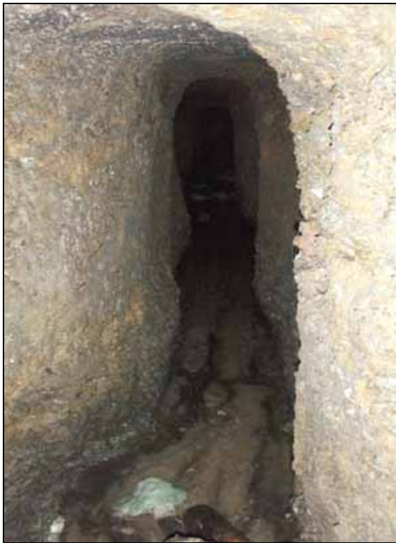
Abb. 26: Nördlichster Punkt des gesamten Stollensystems direkt nach dem Übergang von den 1,2 m großen Betonrohren. (Foto Horst Geiger)
