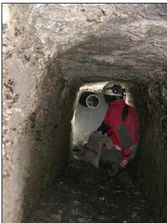
Abb. 18: Achim Lehmkuhl am verfüllten Ende des Stollens. Direkt über dem Rohr befinden sich an der Decke die größten Tropfsteine des Stollens mit einer Länge von ca. 5 cm.
