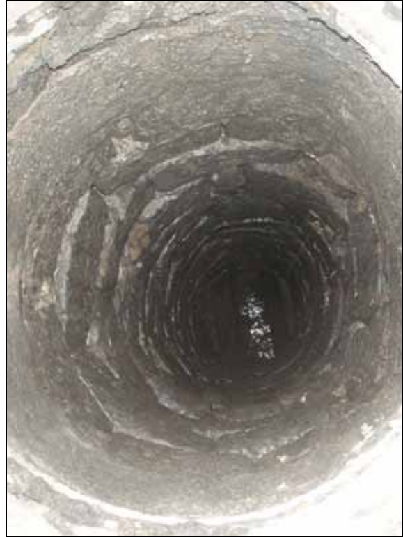
Abb. 22: Blick in den südlichen Naturstein-Kontrollschacht. (Foto Horst Geiger)
