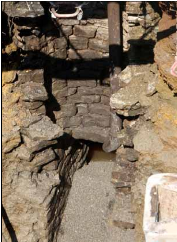
Abb. 23: Nördlicher Kontrollschacht seinem Abbruch am 31. März 2009. Gut zu erkennen ist der horizontale Sturz, der den Stollen überspannte. (Foto Horst Geiger)
