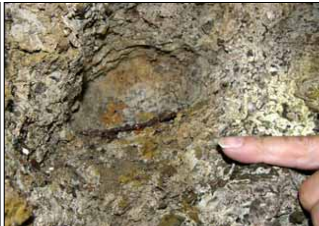
Abb. 15: Wandnische direkt unterhalb der Stollendecke mit einem verrosteten Nagel.
