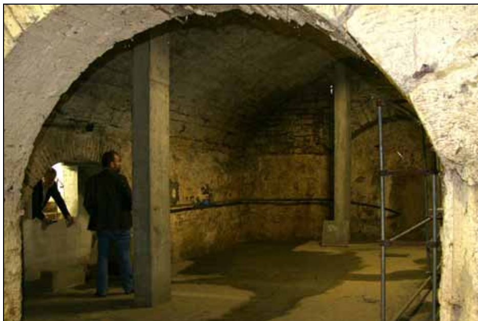
Abb. 25: Der Westteil des Eiskellers unter dem Gebäude des Willig-Areals. Zu erkennen ist der vermauerte Korbogen und darin eine verschlossene Öffnung in Stollengröße, durch die die Hausanschlussleitung für das Frischwasser hindurchführt.
