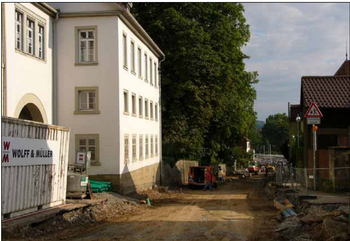
Abb. 2: Blick von der Löwenkreuzung nach Süden in die Hunnenstraße auf die Baumaßnahme mit Neuverlegung der Abwasserkanäle. Der Eingang zum Stollen befindet sich unter dem Dreibock rechts neben dem roten Kastenwagen; links das Gebäude des Amtsgerichts.
