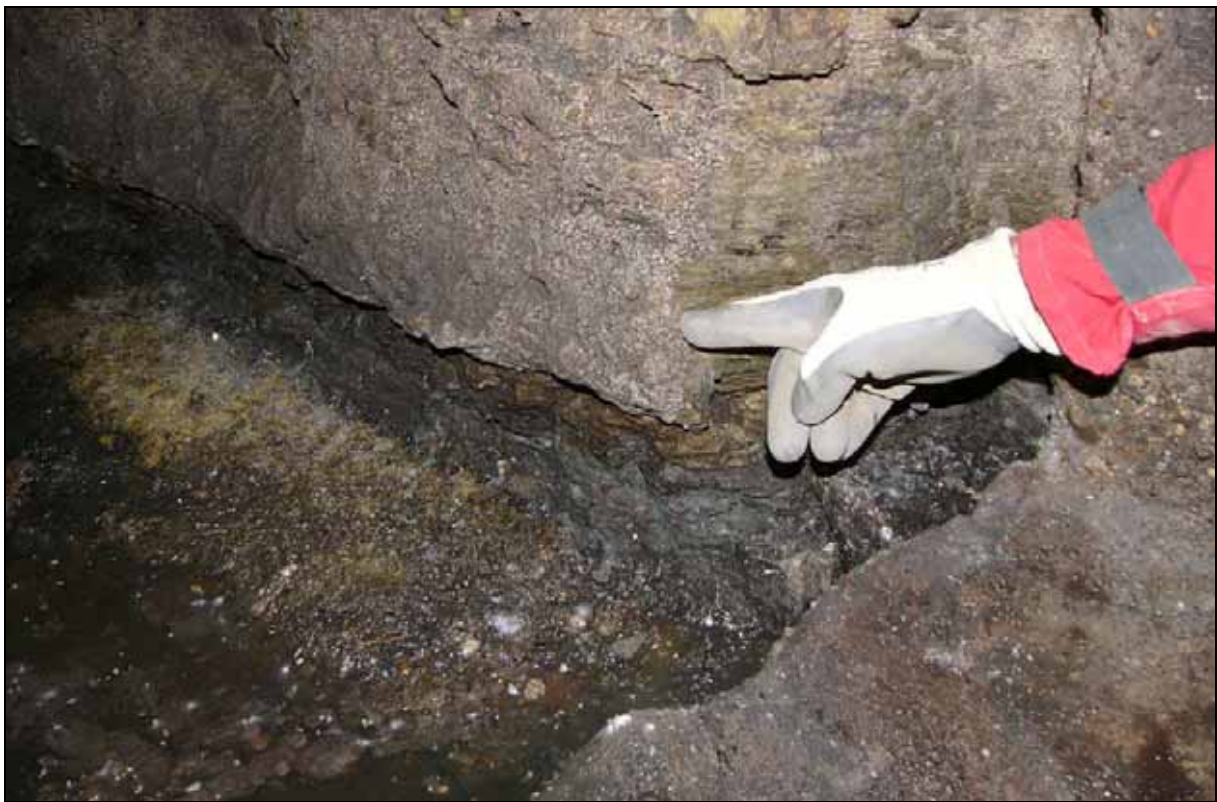
Abb. 9: Die rechte Seite des Stollenmunds mit verschmutztem Wandsinter vor der Entnahme einer Probe. Unterhalb des Sinters sind die farbigen Mergelschichten des Lettenkeupers zu sehen. Die Grenzlinie zwischen Sinter und anstehendem Gestein dürfte die ehemalige Stollensohle anzeigen, denn es ist anzunehmen, dass beim Bau des Kontrollschachtes die Sohle geringfügig tiefer gelegt wurde. Links die fäkalienhaltigen Abwässer, die einen üblen Geruch verbreiteten.
