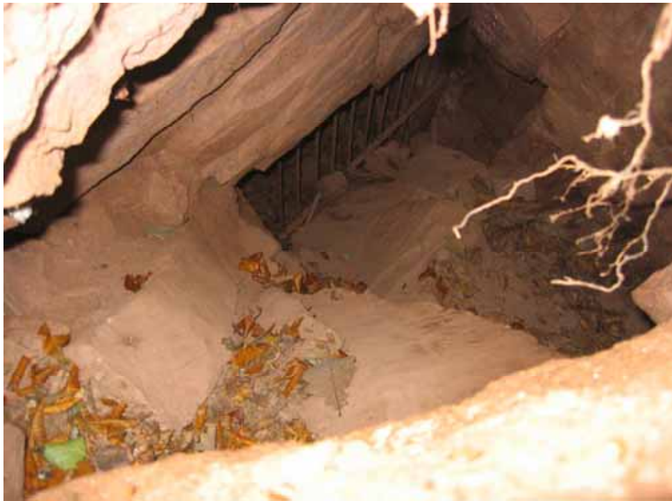
Abb. 18: Verschütteter Eingang des St. Georg-Stollens
