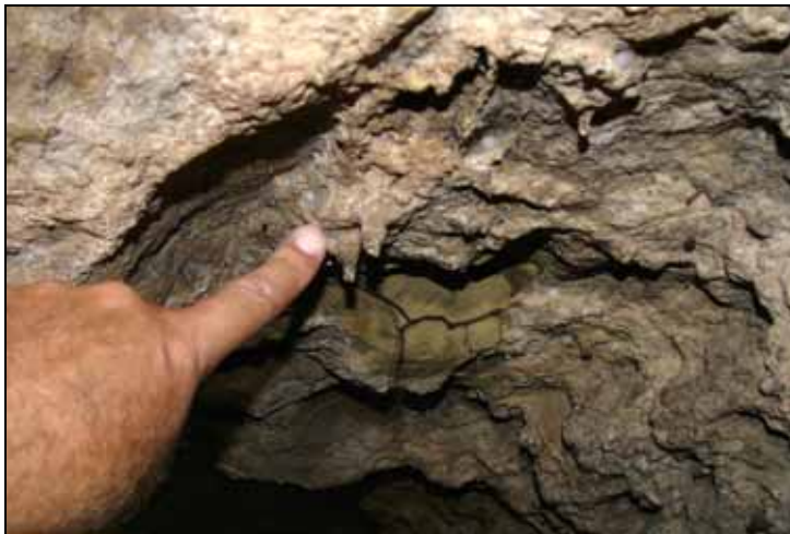
Abb. 12: Ausgetrocknete Sinterröhrchen unter der Stollenfirste. Dahinter ist durch einen Gesteinsspalt eine Baumwurzel bis in den Stollen vorgedrungen. Infolge ihres Dickenwachstums wurde die Gesteinsoberfläche mit dem anhaftenden Sinter weggesprengt, wodurch die auffällige sinterfreie Stelle entstanden ist.
