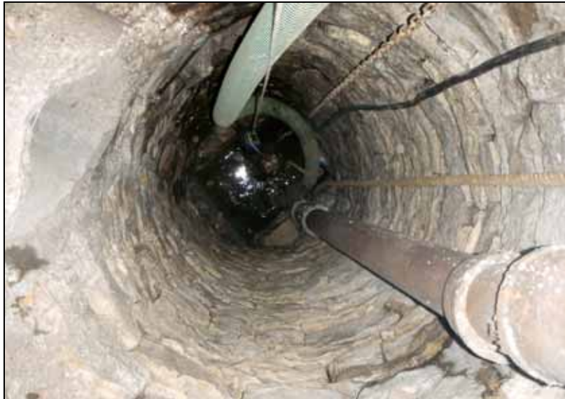
Abb. 20: Blick nach unten in den nördlichen Naturstein-Kontrollschacht. Am Grund ist das im Stollen fließende Abwasser zu erkennen. (Foto Horst Geiger)
