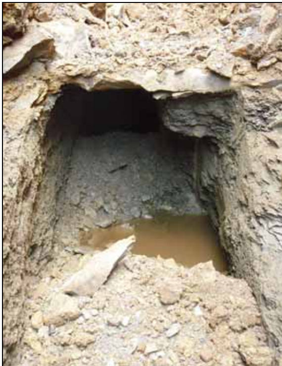
Abb. 28: Eine ca. 15 cm starke Dolomitbank bildete streckenweise das Dach des Stollens; Aufnahme vom 17. September 2010. (Foto Horst Geiger)
