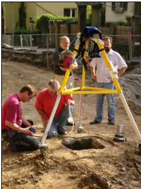
Abb. 3: Markus Brecht und Wolfram Pachel vom städtischen Bauhof Öhringen am Schachteinstieg bei der Installation der Gasmessanlage; dahinter Thomas Rathgeber und Horst Geiger.
