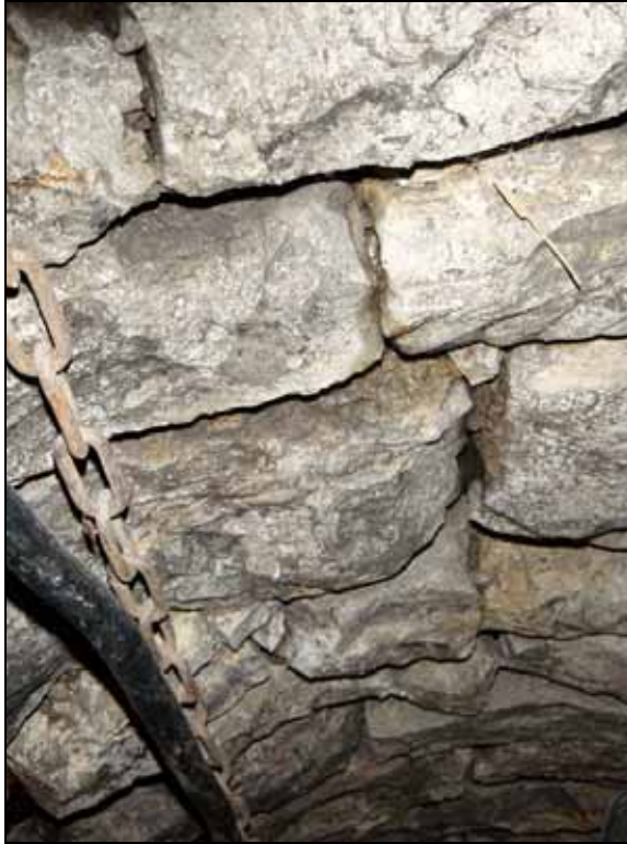
Abb. 21: Das im Naturstein-Kontrollschacht Nord mörtellos aufgeschichtete Trockenmauerwerk im Detail. (Foto Horst Geiger)
