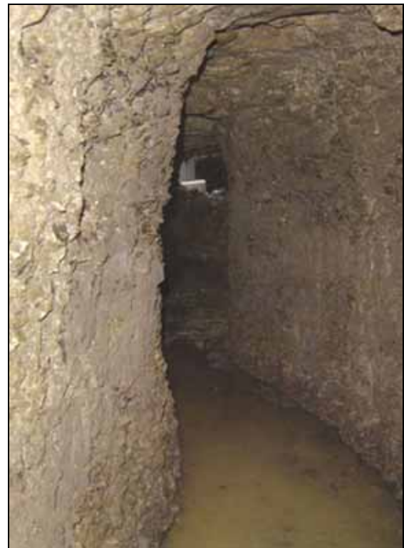
Abb. 17: Dieselbe Stelle wenige Tage zuvor, am 14. Juli 2010, mit Tageslichteinfall, weil hier während der Bauarbeiten der Stollen angeschnitten wurde (Foto Herr Lehr).
