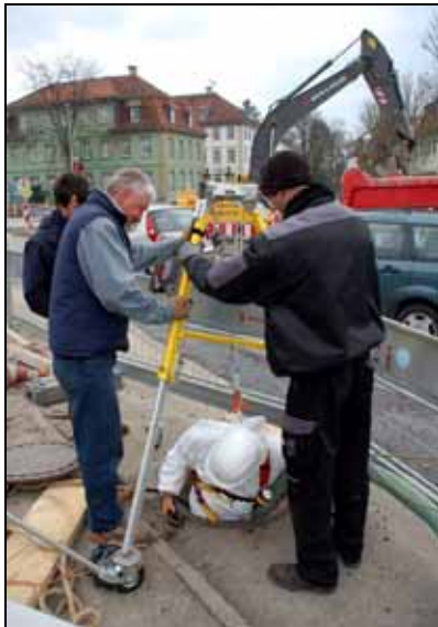
Abb. 19: Befahrung des nördlichen Naturstein-Kontrollschachts am 23. März 2009 durch Horst Geiger. (Foto Tiefbauamt der Stadt Öhringen)
