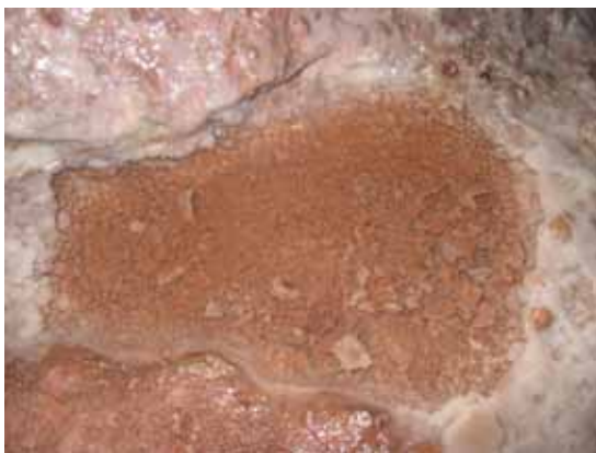
Abb. 10: Sinterbecken im Wasserstollen
