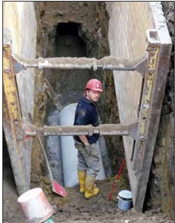
Abb. 29: Heute ist vom Stollen nichts mehr übrig, da die neu verlegten Betonrohre dem Verlauf des Stollens folgen. (Foto Horst Geiger)
