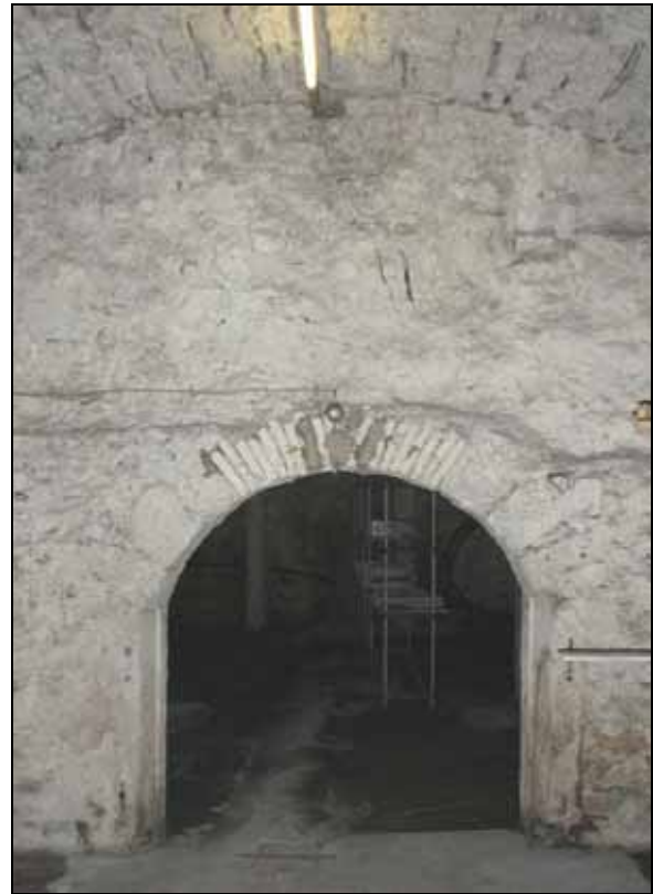
Abb. 24: Der große zweigeteilte Eiskeller unter dem Gebäude des Willig-Areals, Blick nach Westen. (Foto Horst Geiger)
