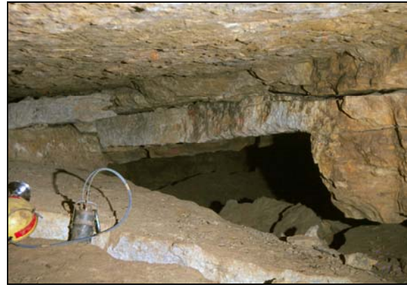
Abb. 5: Einer der weitgespannten, flachen Verbrauchsräume des Fuchslabyrinths zwischen „Saurierhalle“ und „Sandwich“ – vorne am Boden Versturzböcke, hinten das typisch sandig-lemmige Höhlensediment (Foto: Th. Rathgeber).
